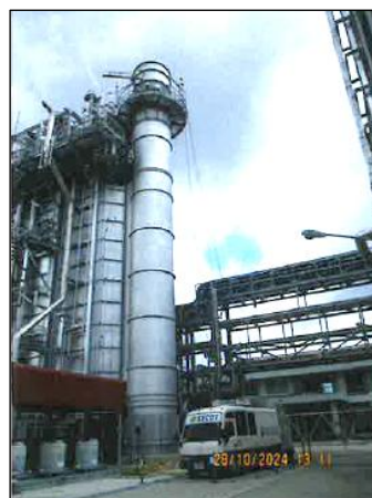
รูปที่ 3.3 การเก็บตัวอย่างคุณภาพอากาศจากแหล่งกำเนิด บริเวณปล่อง HRSG#6
